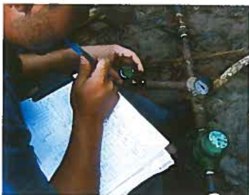
Cap. 7: Ensaio de perda d'água.
