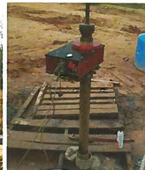
Cap. 11: Ensaio especial em solo: execução do vane test.
