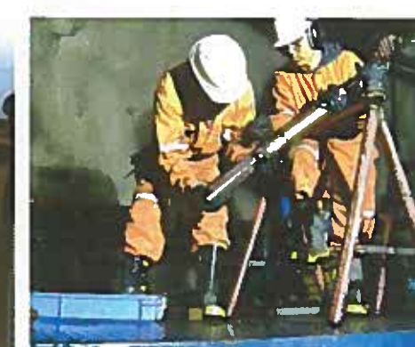
Cap. 12: Sondagem rotativa.
