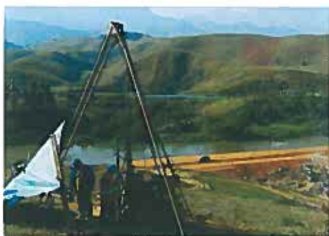
Cap. 5: Sondagem rotativa.
