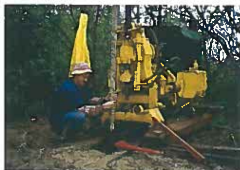
Cap. 5: Sondagem rotativa: instalação piezômetro.
