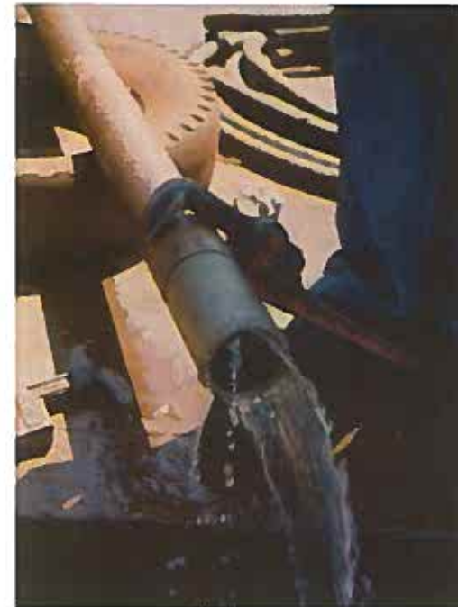
Cap. 5: Sondagem rotativa: barrilete duplo-livre de 86 mm, Série T (paredes finas).
