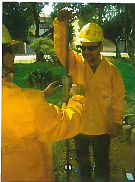
Cap. 12: Ensaio de penetração em Barramina - SOPEL - Geotecnia e Fundações Ltda
