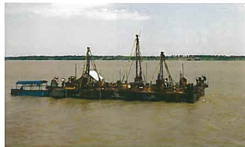
Cap. 5: Sondagem rotativa em balsa no Rio Paraná.
